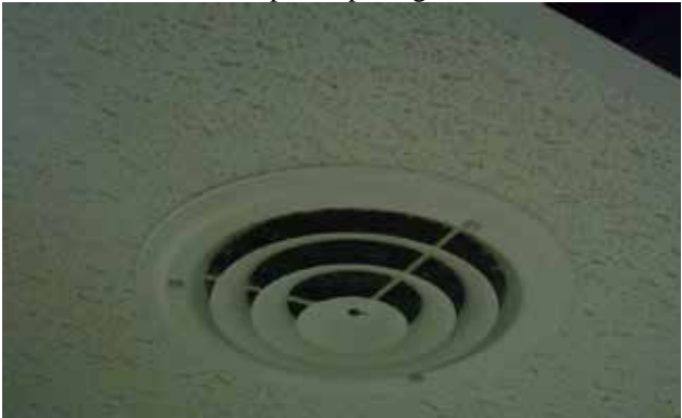
Exhaust fan diffuser.
